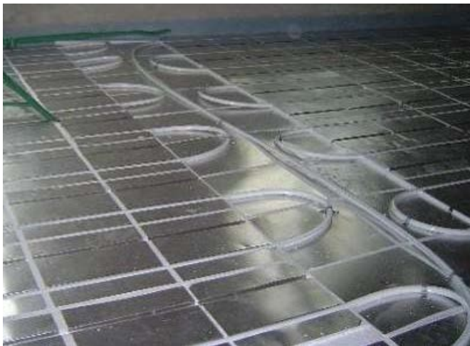
Käntölevyn asennuseriaate.
