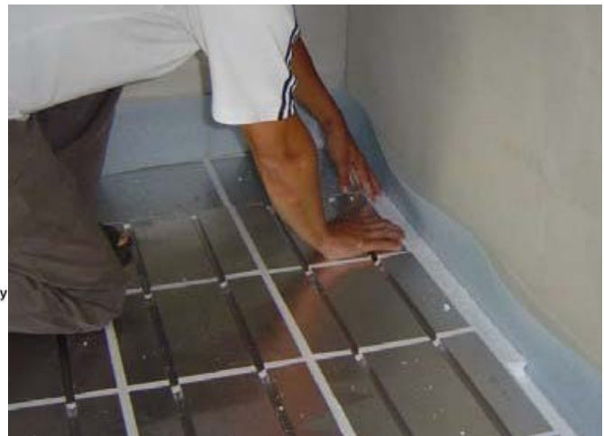
Reunanauhan ja Comfort Lämpölattialevyjen asentaminen.
