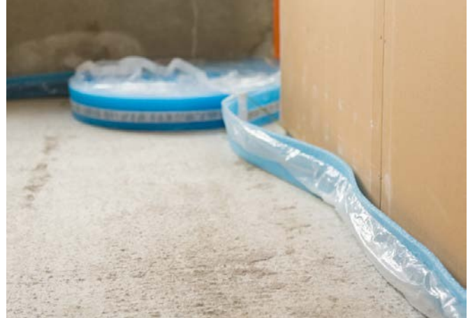
weberfloor 4960 Reunanauhan asennus.
